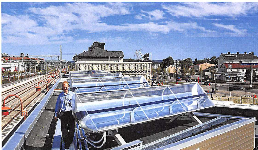
På Resecentrum i Härnösand har Absolicon installerat 42 m 2 koncentrerande solfångare.
