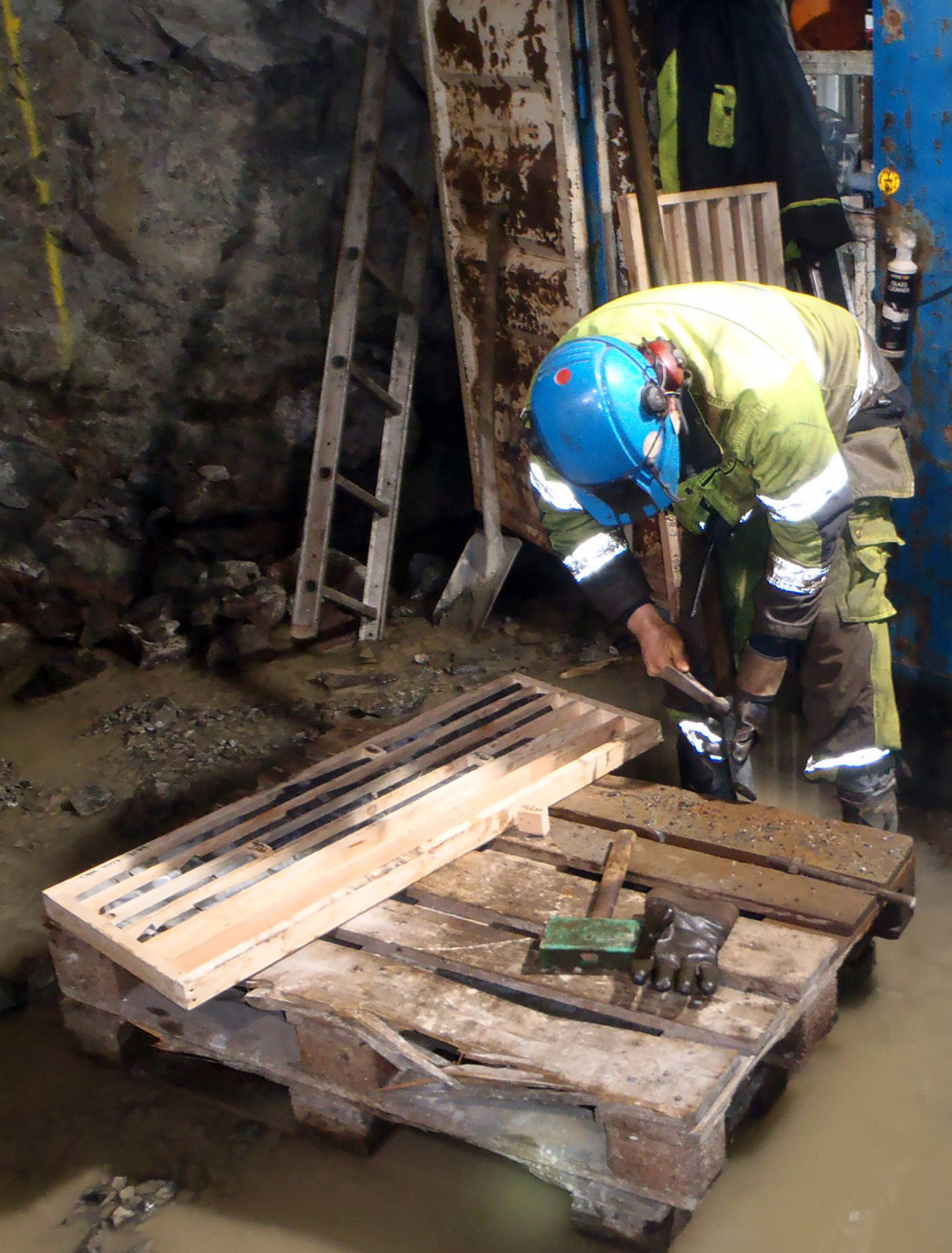
HÅKAN FRÅN DRILLCON TÖMMER UT BORRKÄRNOR FRÅN BORRÖRET
