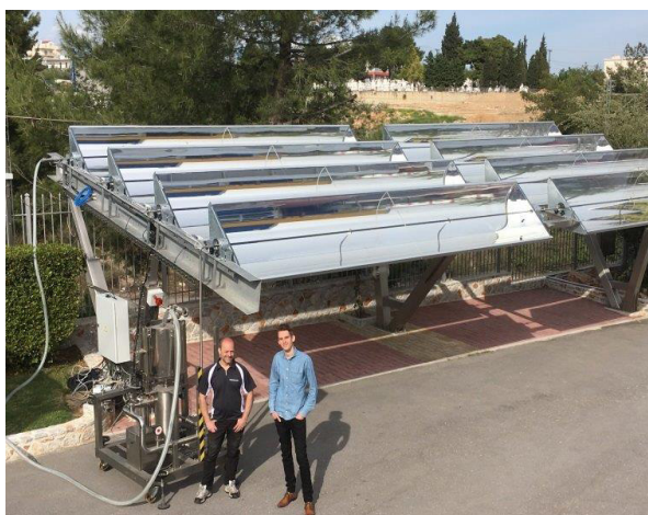
Installation av Absolicons solfångare i Saravanos, Grekland
