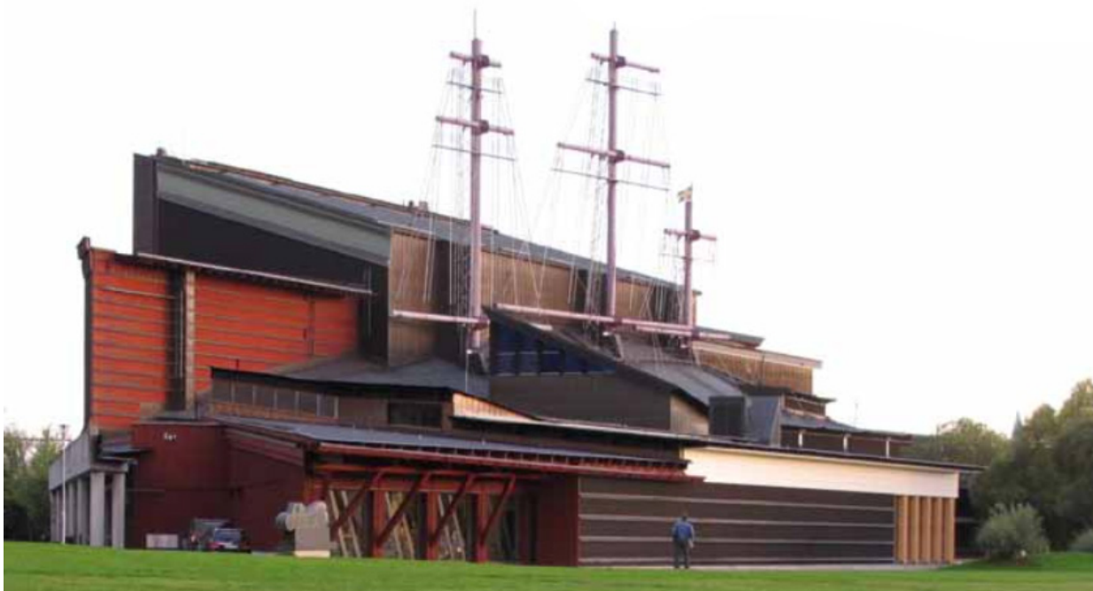
Fastighetsventilation är ett stort marknadssegment för NFO Drives och Vasamuseet i Stockholm är en av årets många kunder. Genom att välja omriktaren NFO Sinus® fick man en störningsfri och energieffektiv styrning av ventilationen i den nybyggda delen av fastigheten.
